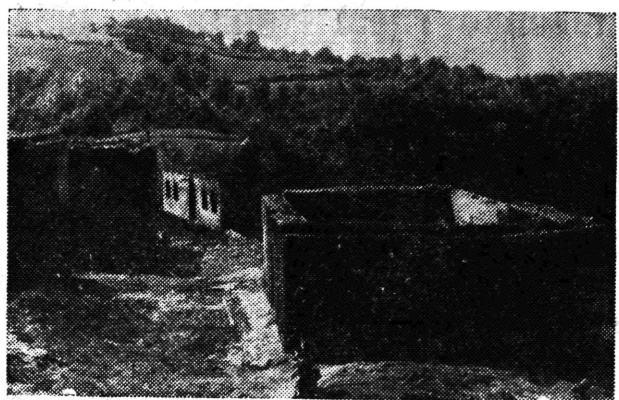
Uništene kuće poslije požara u Delivukima
