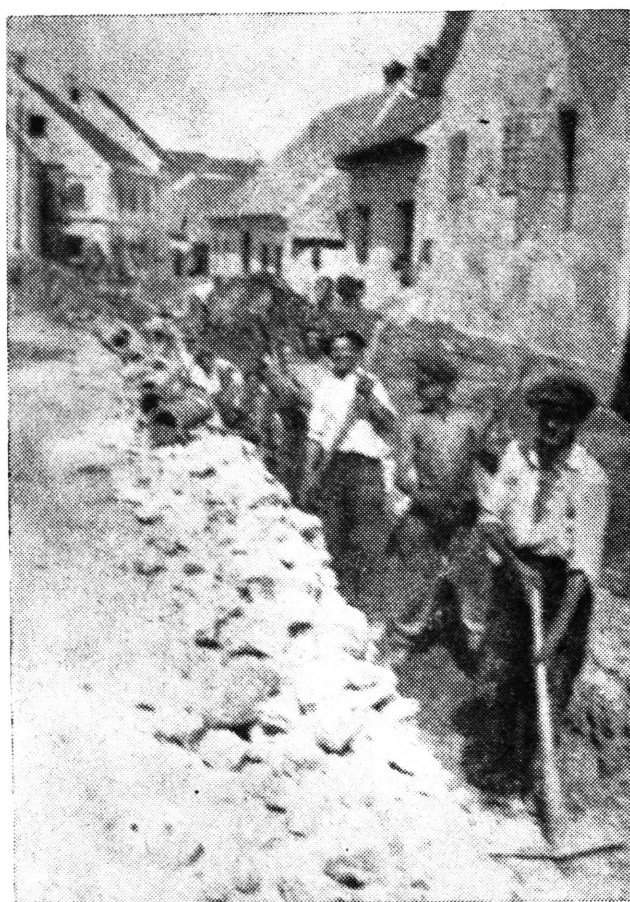
Iskop grabe za uporednu vodovodnu cijev u Starogradskoj ul. u toku radova ove godine
