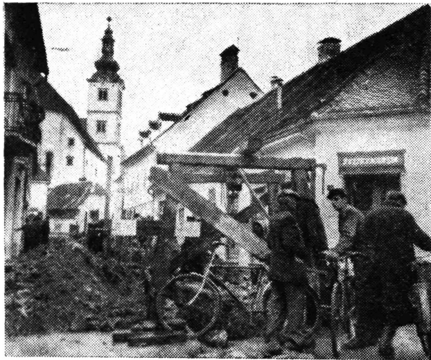
Radovi na kanalizaciji Perkovčeve ulice u 1956. godini
