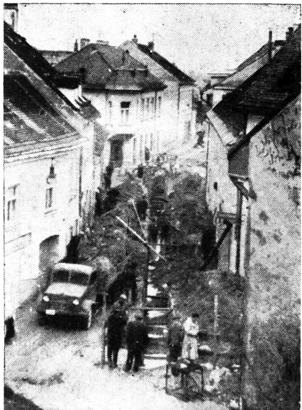
Ovako je izgledala Perkovčeva ulica ovih dana za radova na kanalizaciji
