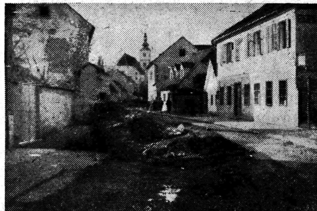
Perkovčeva ulica za nedavnih radova na kanalizaciji
