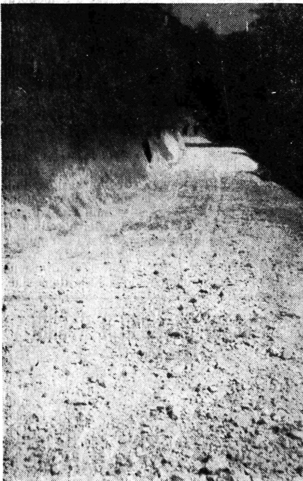
Rezultat rada nije izostao . . . izgrađen je put Noršić selo-Grdanjci
